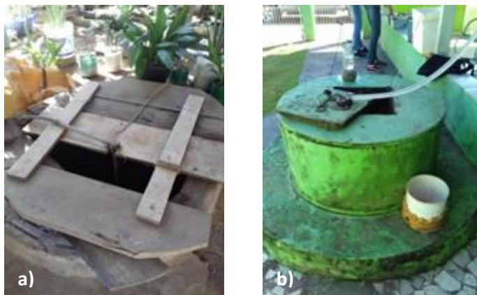
Figura 12- a) Poço 4 com tampa de madeira e b) Poço 6 com tampa de alvenaria ambos em Presidente Médici. Fonte: Os organizadores.
