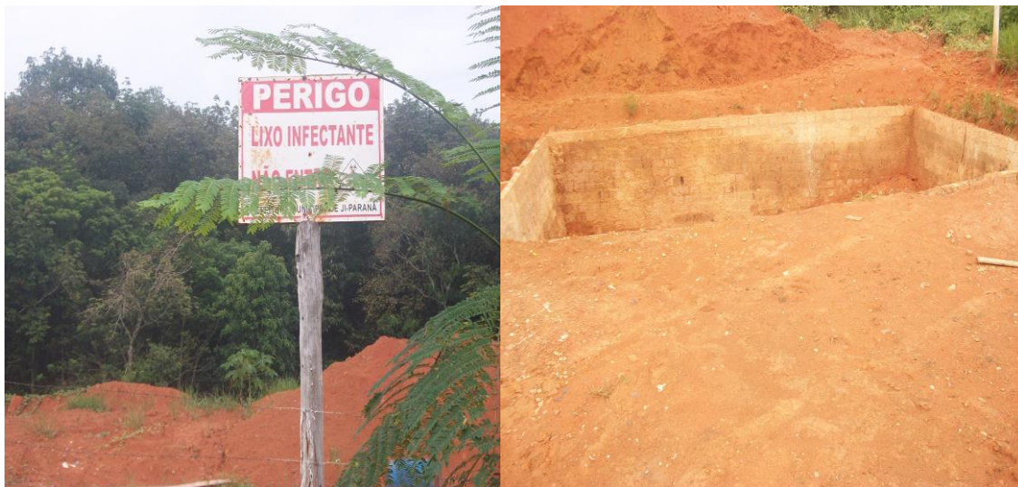
Figura 21. Vala de deposição dos resíduos sólidos dos serviços de saúde. Fonte: organizadores (2011)
