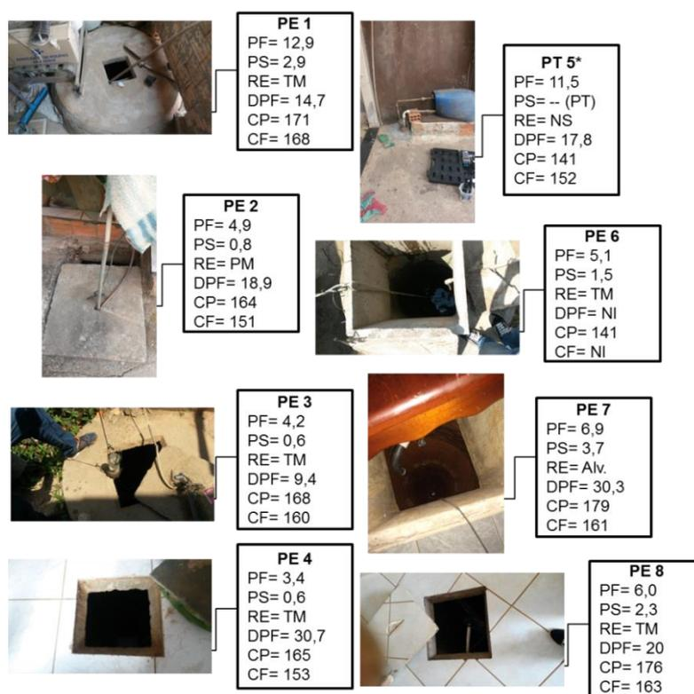
**Figura 2:** Registro fotográfico das tampas e aspectos hidrossanitários dos poços 1 ao 8 amostrados na microbacia do Igarapé Dois de Abril. PF= Profundidade de fundo; PS = Profundidade de superfície; RE = Revestimento; DPF= Distância entre o poço e a fossa; CP = Cota Poço; CF= Cota Fossa; TM= Totalmente revestido; PM= Parcialmente revestido; NS= Não soube informar; Alv.= Alvenaria; NI= Fossa não identificada. \* O esgotamento é direcionado para o Igarapé. Fonte: A autora.
